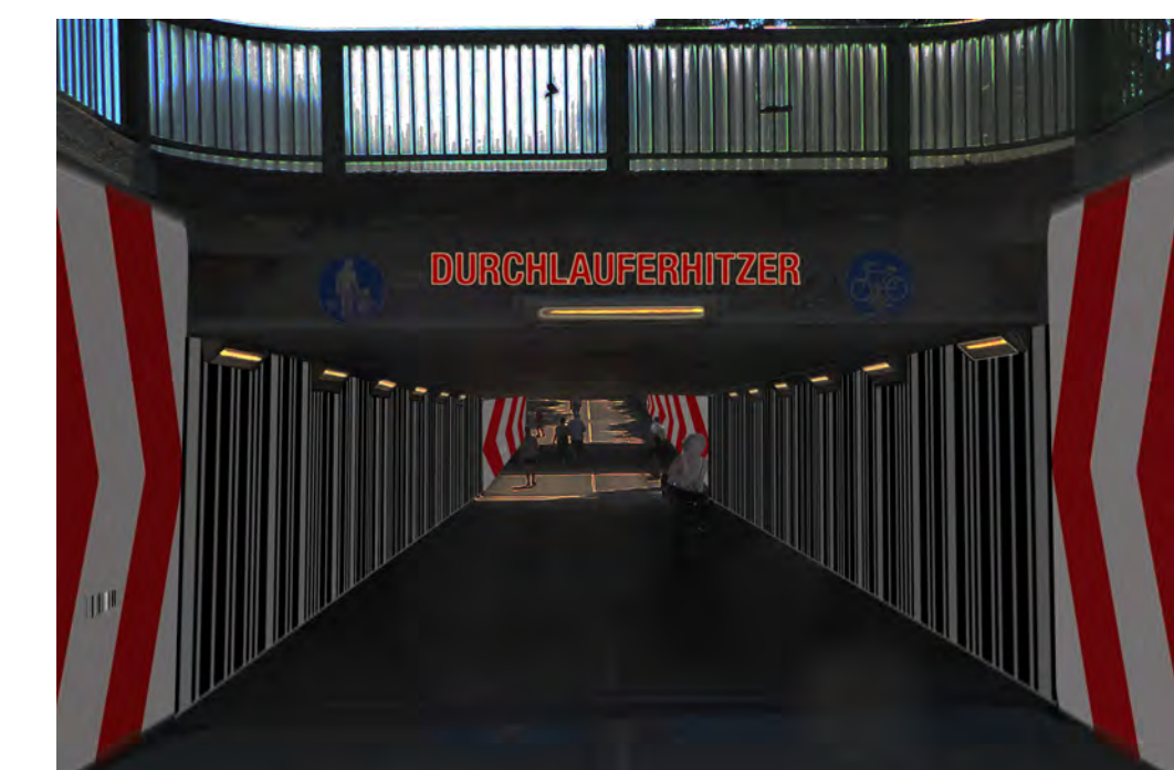
Unterführung, Ansicht bei Dämmerung mit Beleuchtung
